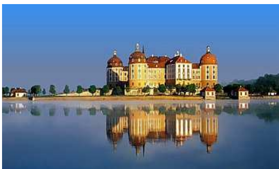
Schloss Moritzburg, technische Ver- und Entsorgung
