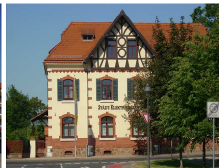
Sanierung Stadtwerke Döbeln
