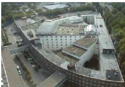
Haus des Rundfunks (HDR) in Berlin
