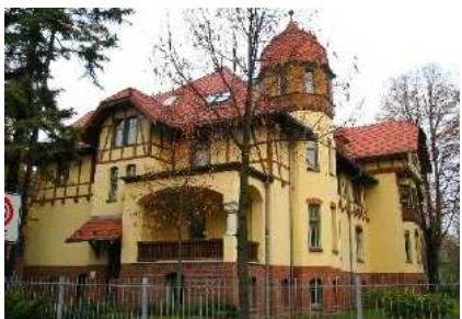
Verwaltungsgebäude DOW in Potsdam
