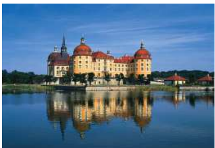
Schloss Moritzburg - komplette Sanierung
