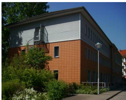
Neubau Landratsamt in Döbeln
