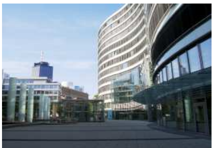
Gebäudekomplex 'Frankfurter Welle', Frankfurt /M
