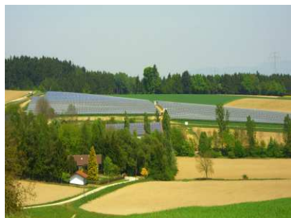
Photovoltaikanlage Oberhörnabach 1.7 MWp
