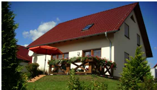
Einfamilienhaus Döbeln - das wahrscheinlich kleinste LVZ-Projekt
