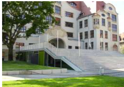
Gutenberg-Gymnasium Erfurt, Komplettsanierung
