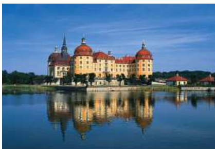
Schloss Moritzburg - komplette Sanierung
